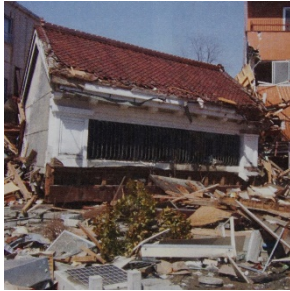
角星店舗：津波で1階は損壊。2階は押し流されたが残置されたのを曳家し調査、全解体再建
