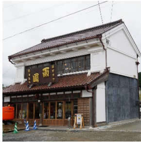
角星店舗：津波で1階は損壊。2階は押し流されたが残置されたのを曳家し調査、全解体再建
