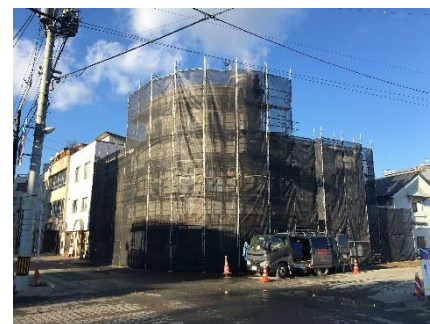
▲修復工事が始まった千田家住宅
